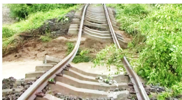
Figura nr. 4: În urma inundațiilor din județul Argeș, a fost distrusă calea ferată între Curtea de Argeș și Pitești 19
